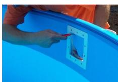
Symbolfoto Skimmer: Flansch nur mit Schraubenzieher (kein Akku-Schrauber!) befestigen. Folie erst ausschneiden, wenn fertig verflanscht und wenn Wasserstand genügend hoch ist!
