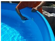
Symbolfoto Düse: Ausschnitt der Folie erst, wenn der Wasserstand entsprechend hoch ist! Bei Einbau von Düsen unter dem Erdniveau nicht die im Skimmer beige-packte Düse verwenden, sondern die Düse mit Flansch Typ O330 Art.Nr. 67762, sodass Sie nach Jahren auch problemlos einen Folientausch durchführen können.
